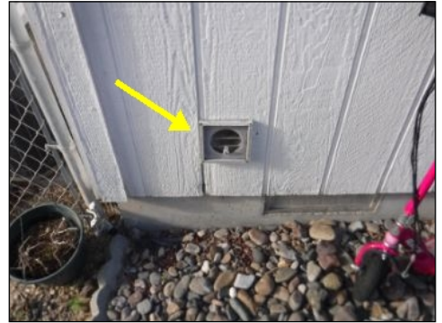
damaged vent slats
